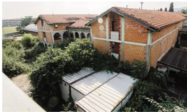
L'ex convento delle Clarisse a Boccaleone, area dismessa che il Comune vuole acquisire per poi demolire gli edifici fatiscenti
